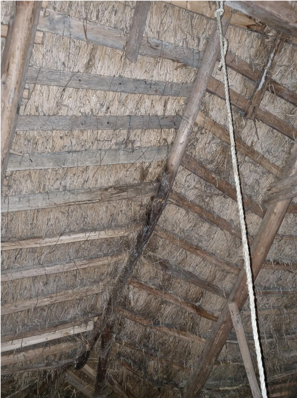
Figur 7 Viser råd i spær på kvist
